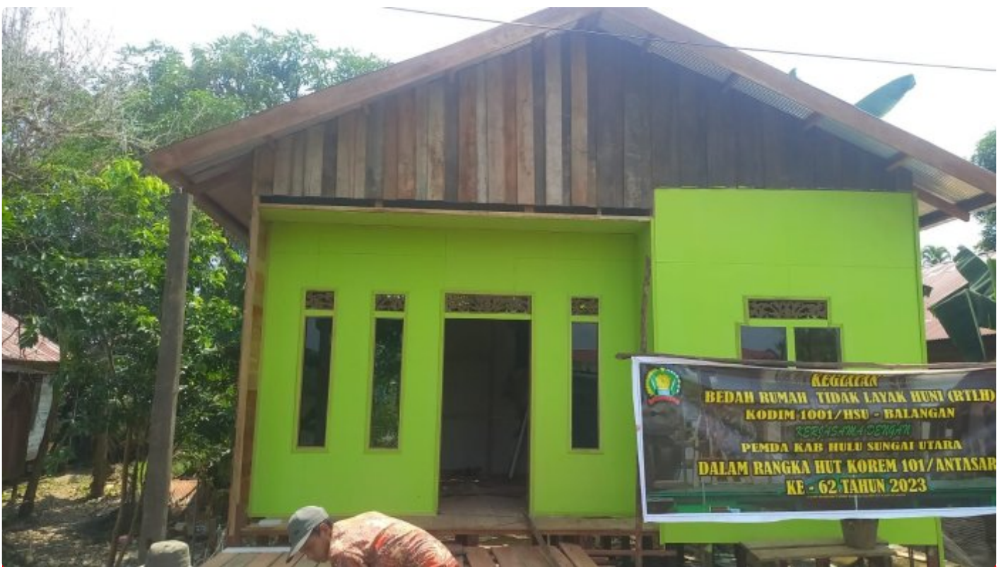
Kodim 1001/HSU-BIG Bedah Rumah Tidak Layak Huni Sambut HUT Korem 101/Antasari
